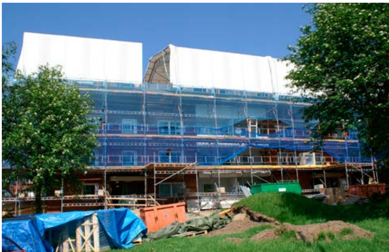
Renoveringar på Ålidhem.
